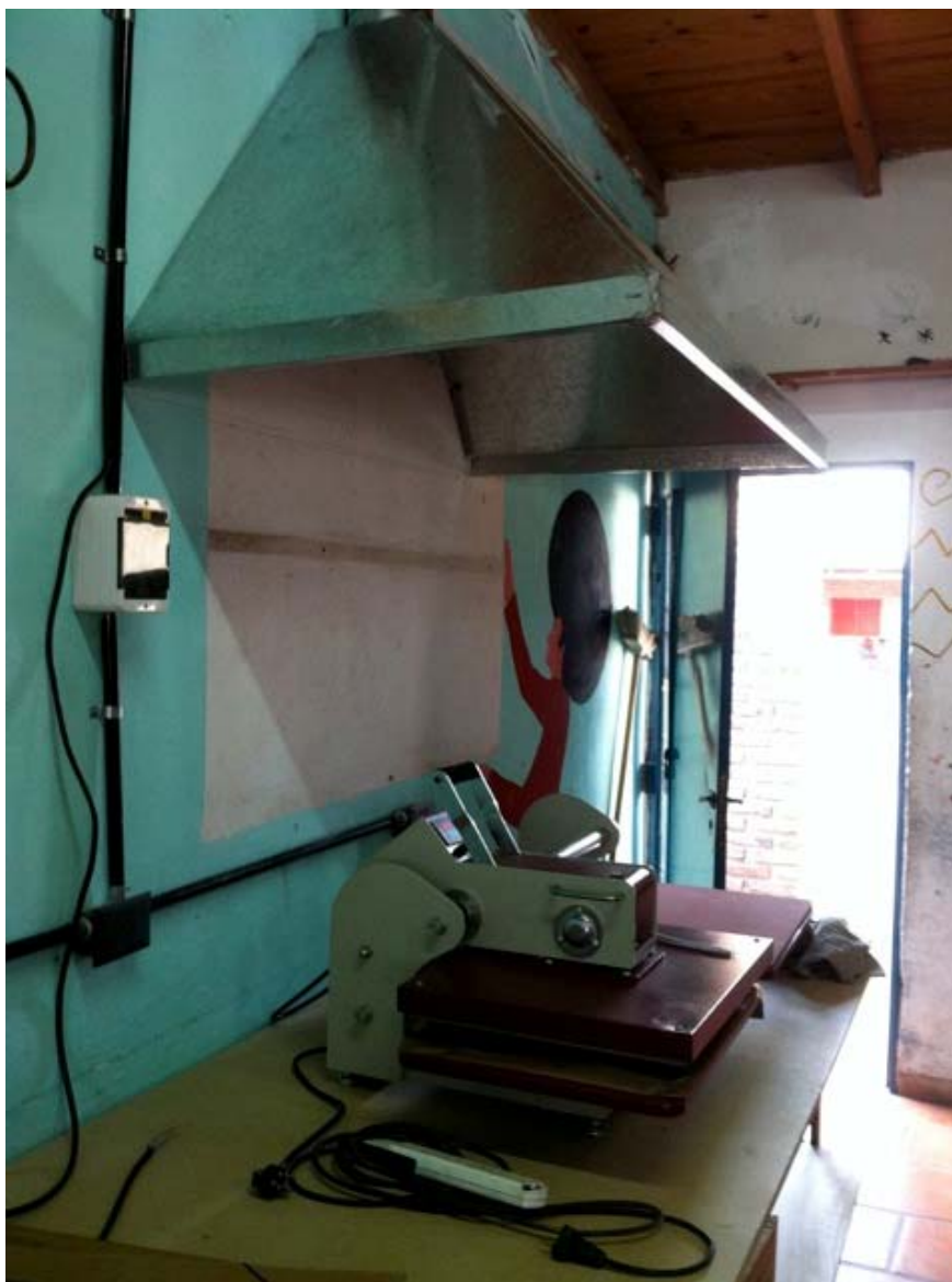
FOTO 11: Instalación de Prensa y campana extractora
