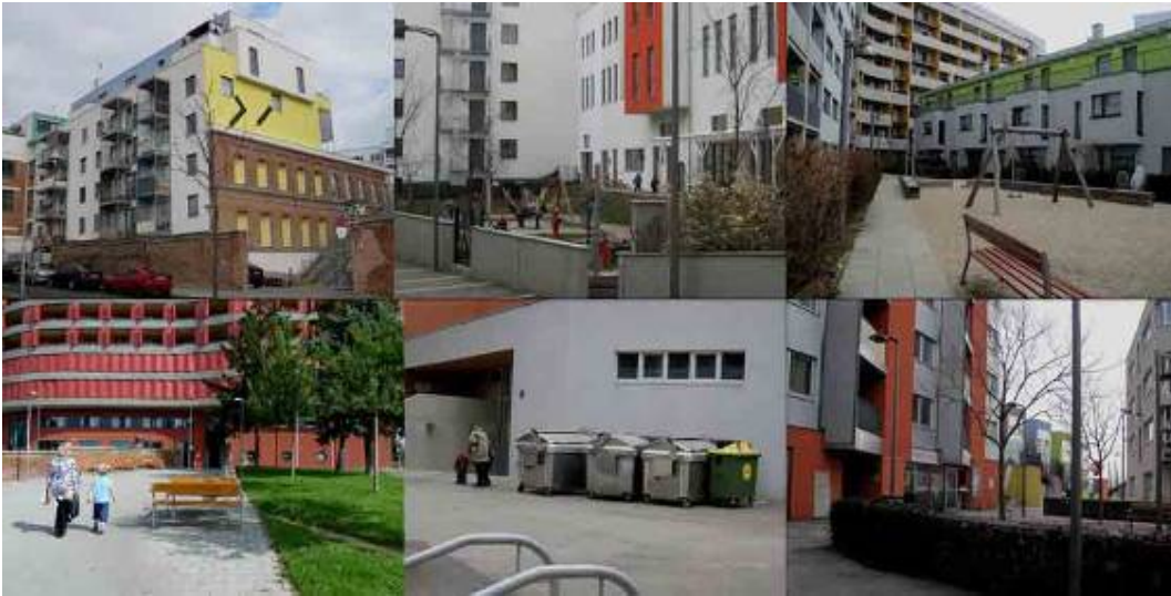
Imágenes espacio público: accesos, plazas, infraestructura. Archivo CEHyV 2012
