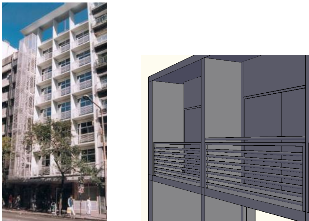
Figura 1. Fachada del edificio y detalle de balcones
